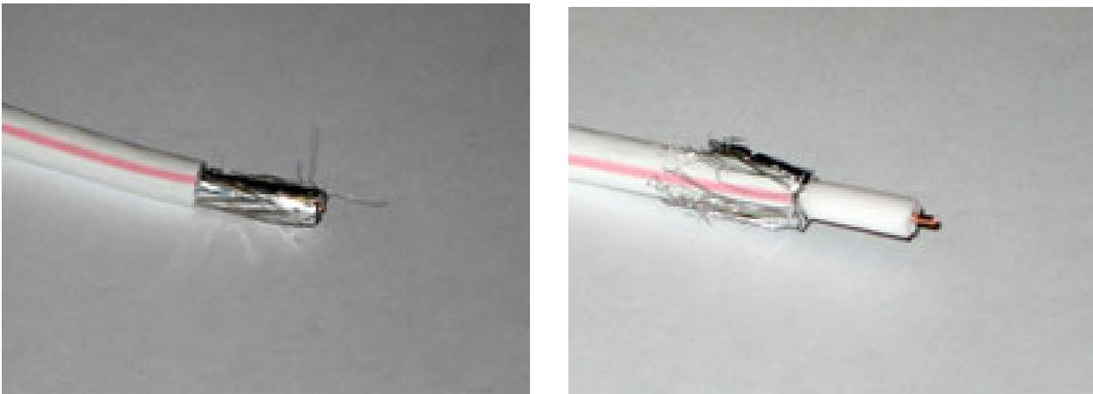
Снимите изоляцию и расправьте в противоположном положении от конца кабеля поверх кабельной изоляции оплетку и фольгу.
